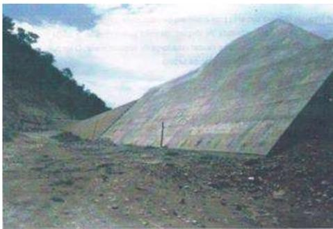
Figura 18 - Canal do vertedouro lateral e muro de encosto da barragem.
