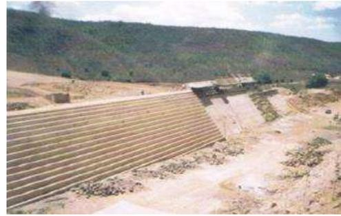
Figura 17 – Algodões - Vertedouro.
