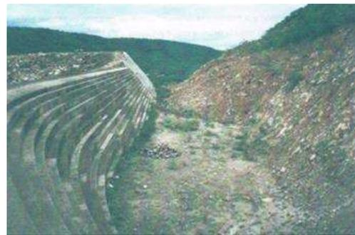
Figura 19 – Escorregamento do talude do canal.
