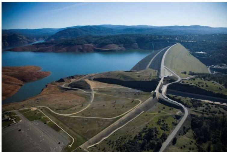
Figura 61 – Vertedouro de emergência em primeiro plano, vertedouro de serviço e barragem ao fundo Fonte: MAGELA, 2017.
