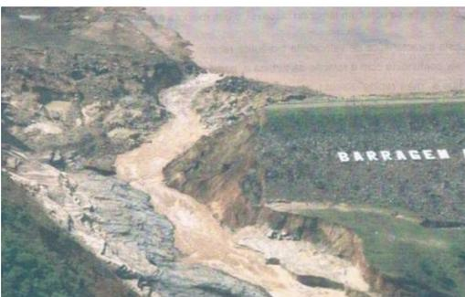
Figura 20 – Algodões. Barragem rompida.
