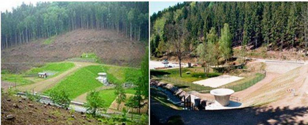
Figura 60 - Barragem Glashütte reconstruída. Observar vertedouro tulipa.
