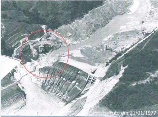
Figura 11 – Euclides da Cunha. Ruptura.
