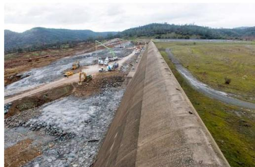
Figura 68 – Vertedouro de emergência. Reparos emergenciais, com blocos de rocha.
