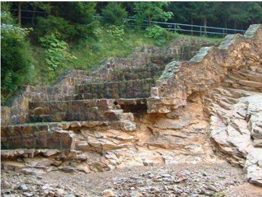
Figura 58 – Vertedouro em degraus.
