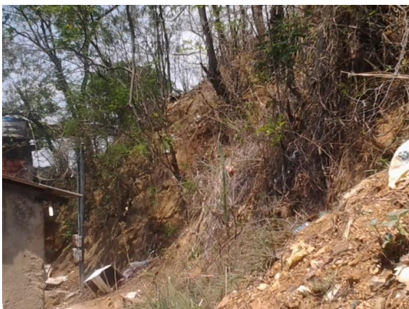
Figura 1 – Corte de talude em ângulo de aproximadamente 90° e erosão intensa, próximo à residência sem contenção.
