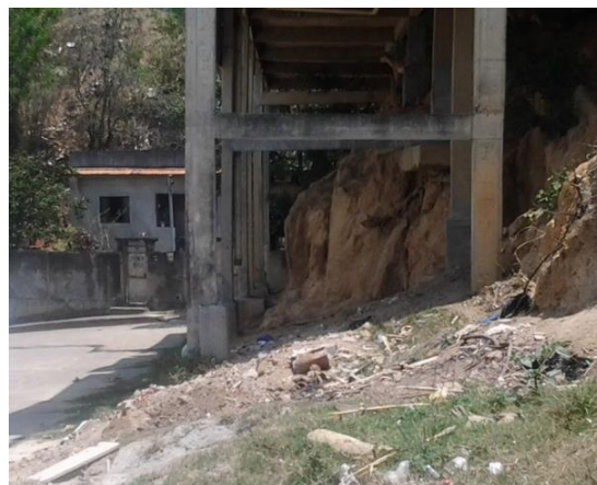
Figura 2 – Bases estruturais de construções aparentes, associadas à erosão do solo.
