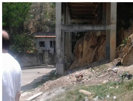
Figura 2 – Bases estruturais de construções aparentes, associadas à erosão do solo.
