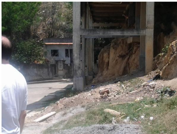
Figura 5 - Bases estruturais de construções aparentes, associado à erosão do solo.
