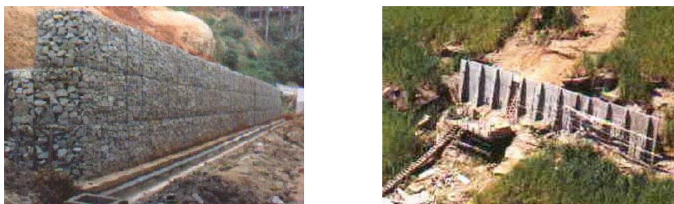
Figura 5 - Fotos de Muros de Arrimo
