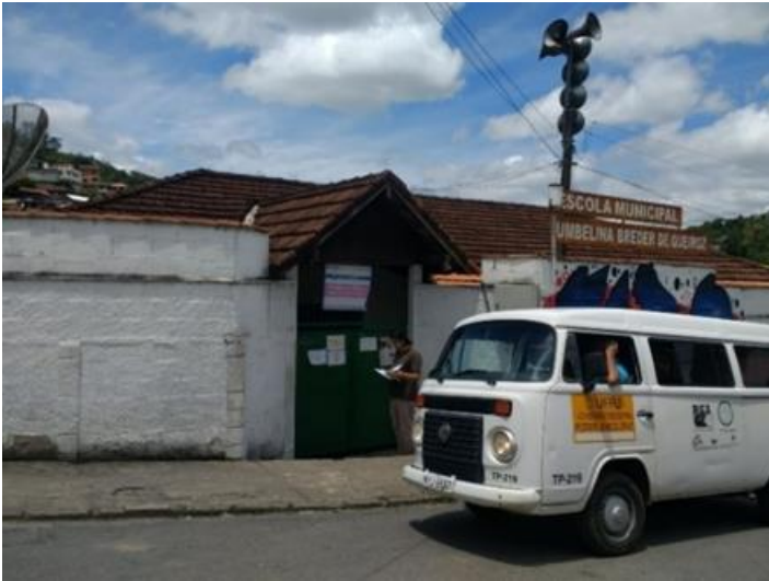
Figura 11: Foto do AE 5 e em evidencia aparece a Sirene do sistema de alerta e alarme.
