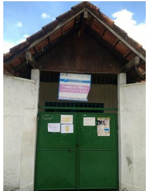
Figura 12: Foto do AE 5, evidenciando a placa da Defesa Civil Municipal com a indicação de AE.
