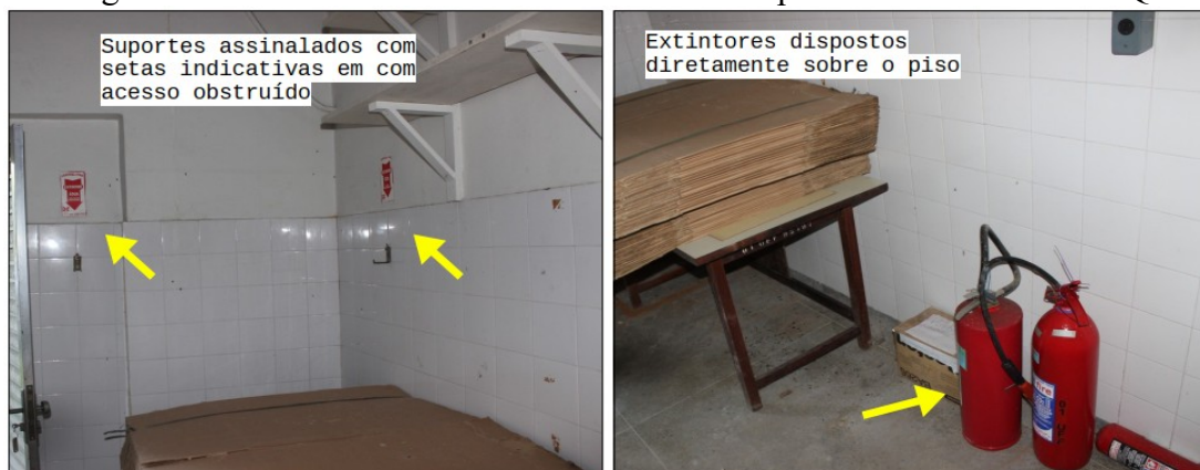
Figura 14 - Detalhe de extintores de incêndio e suportes na sala A do CR-IQ
