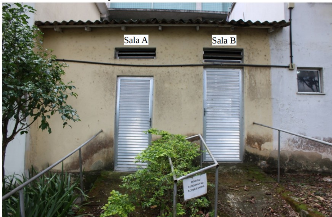
Figura 12 - Vista de frente da CR-IQ
