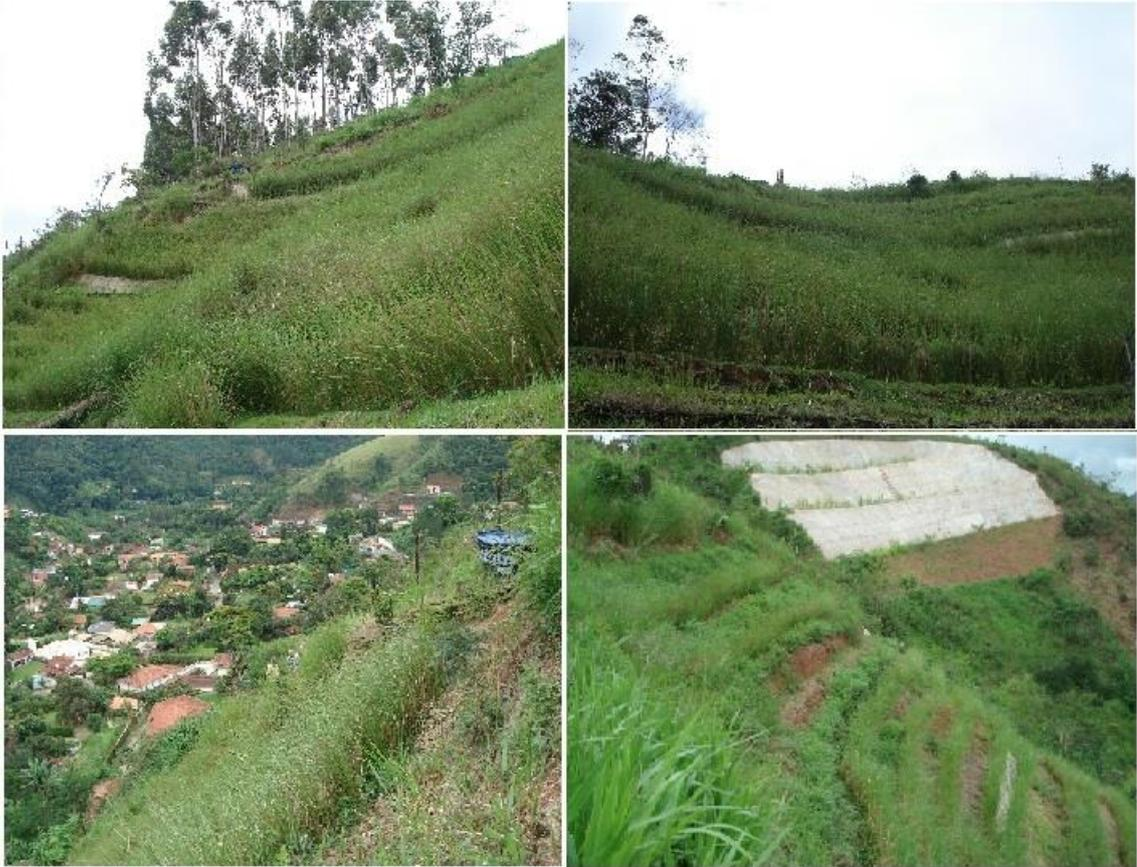
Figura 3: Encosta vegetada com vetiver em Itaipava-RJ
