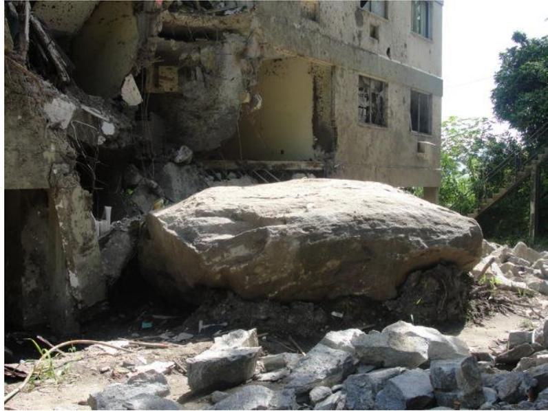
Foto 6: Deslizamento de rocha no CHaPA (outro ângulo)
