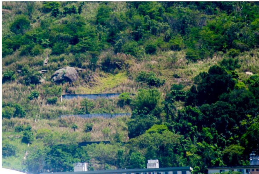
Foto 10: Muretas de contenção e descida em degraus
