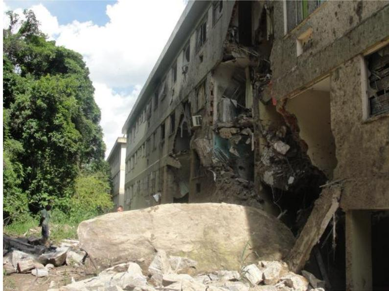
Foto 8: Deslizamento de rocha e danos materiais no CHaPA
