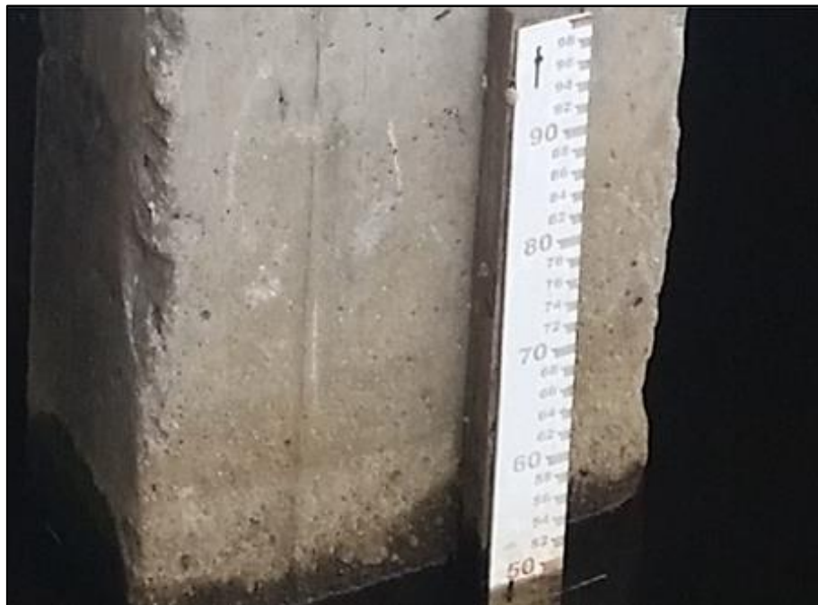
Figura 36 i Nível d'água a montante das comportas do lado esquerdo do vertedouro
