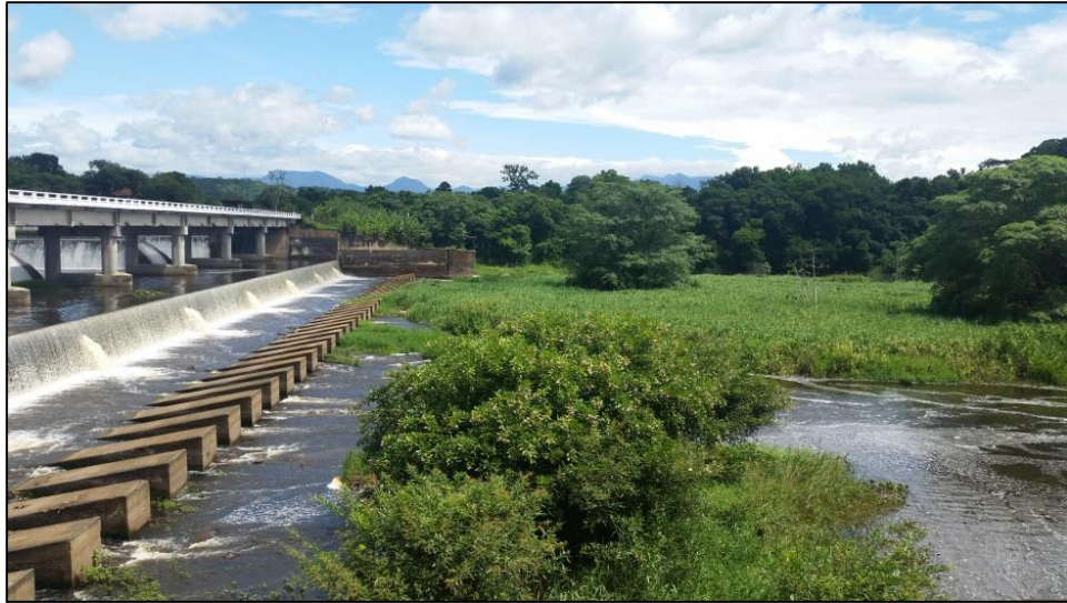
Figura 44 ĩ Ilhas a jusante e próximas das estruturas hidráulicas da barragem
