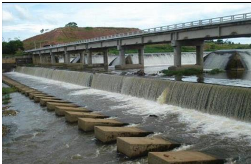
Figura 13 ĩ Vista por jusante da ponte de interligação. Observar o morro sem cobertura vegetal.
