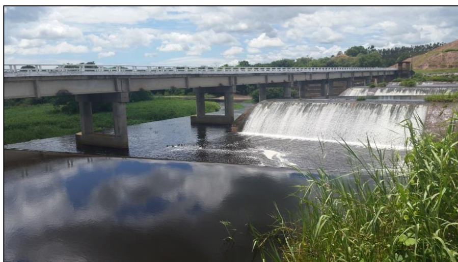
Figura 41 ï Detalhe para a vegetação a montante e a jusante da barragem
