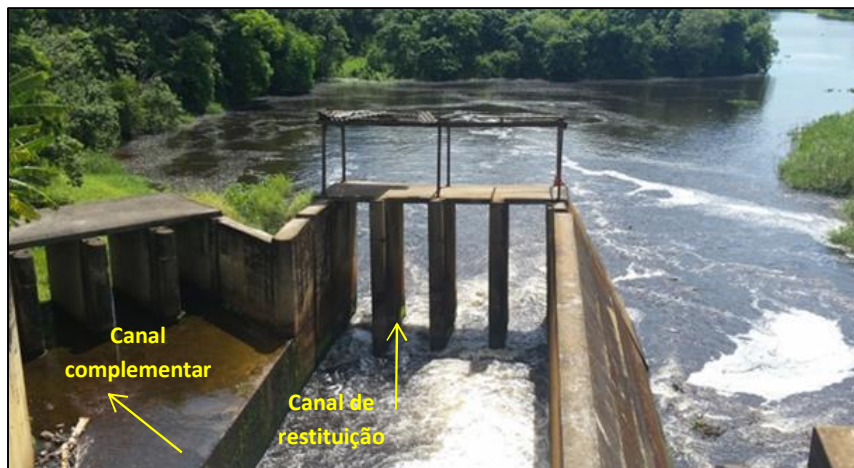
Figura 25 ĩ Canais, de restituição e complementar, do lado esquerdo do vertedouro
