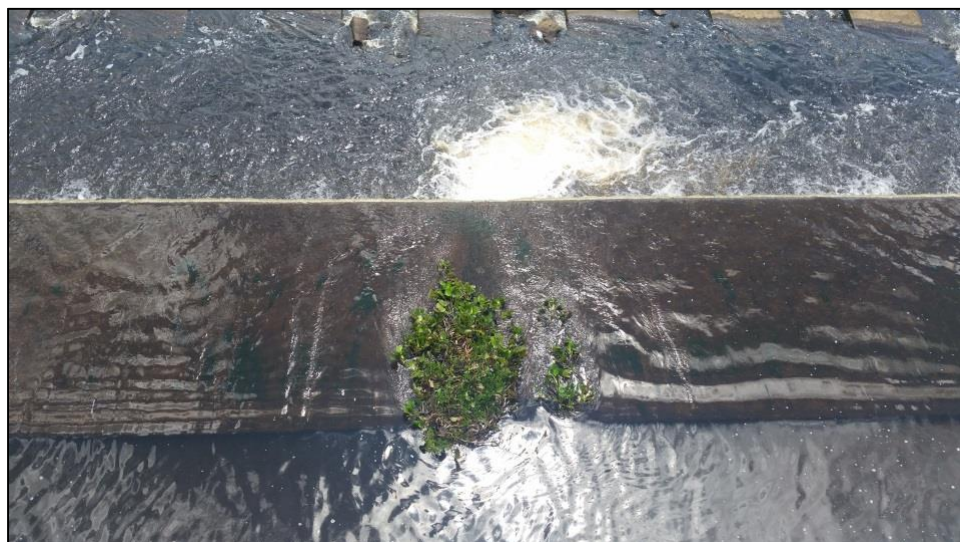
Figura 46 ĩ Passagem de vegetação pelo vertedouro para jusante da barragem
