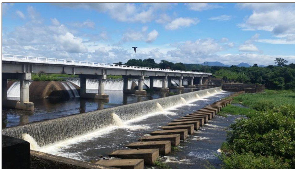
Figura 47 i Vista de jusante da ponte
