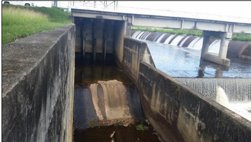
Figura 30 ĩ Comportas do lado direito do vertedouro com desnível para dissipação de energia
