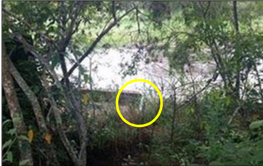
Figura 27 i Vegetação ao redor da margem direita do vertedouro
