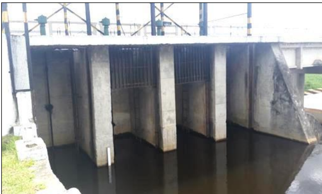
Figura 37 i Detalhe para o gradeamento da face de montante do lado esquerdo do vertedouro
