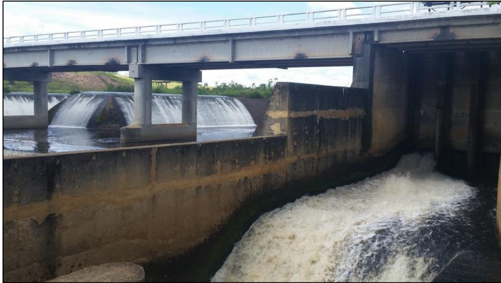
Figura 35 i Comporta da extrema direita do lado esquerdo com detalhe ao fundo do vertedouro
