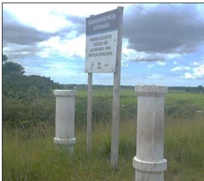
Figura 17 ĩ Placa de proibição de acesso de veículos não autorizados e barreiras
