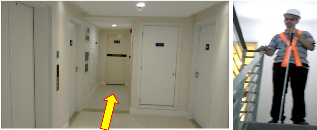
FIGURA 5: Hall do andar com porta corta fogo ao fundo. Deficiente visual descendo as escadas Fonte: O Autor, 2016
