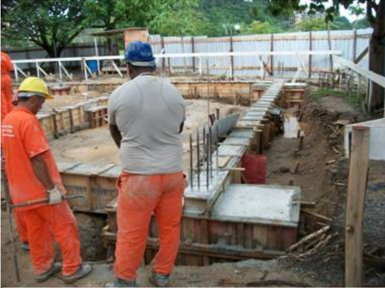
16-Detalhe da barra adicional de diâmetro 10mm erguida junto à armadura de um dos pilares.
