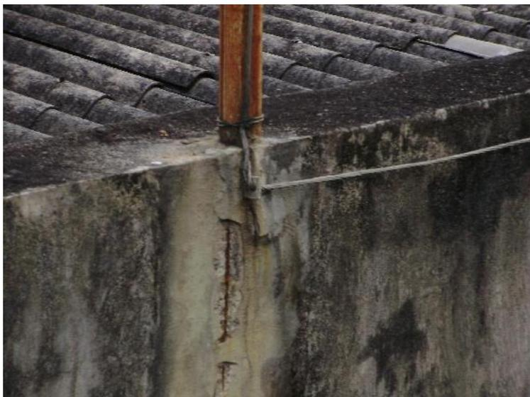
5- Mostra uma construção recente no local onde havia uma caixa de aterramento, pois o cabo de descida encontrava-se cortado e sobre o telhado da nova edificação no Bloco E da Escola de Engenharia, no Campus de Praia Vermelha.
