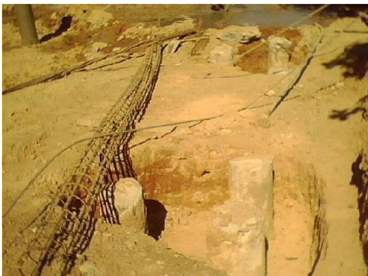
3-Mostra em detalhe a marcação em vermelho da cota de arrasamento de uma estaca da foto anterior. A partir daí o bloco de coroamento será assentado.
