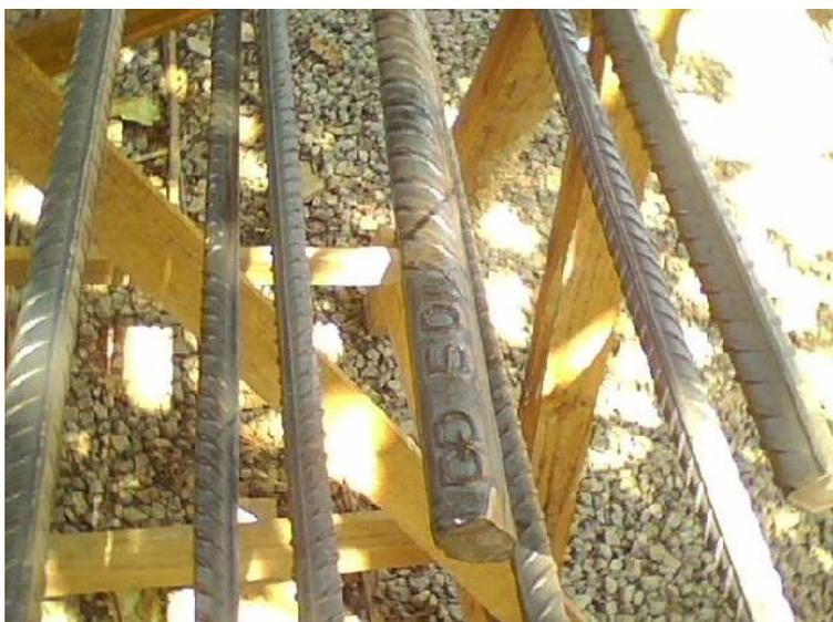
9- Mostra o equipamento rotativo com uma parte da armadura em meio ao concreto, inserida na abertura produzida pela perfuração do solo.
