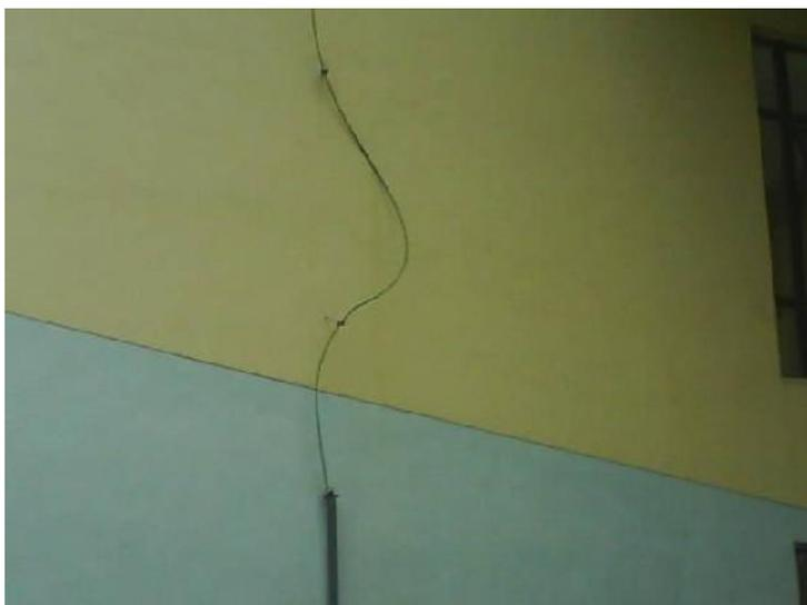
4-A foto abaixo mostra oxidação e falta de isolamento do mastro e do condutor de descida do sistema de proteção convencional do Bloco E da Escola de Engenharia, no Campus de Praia Vermelha.
