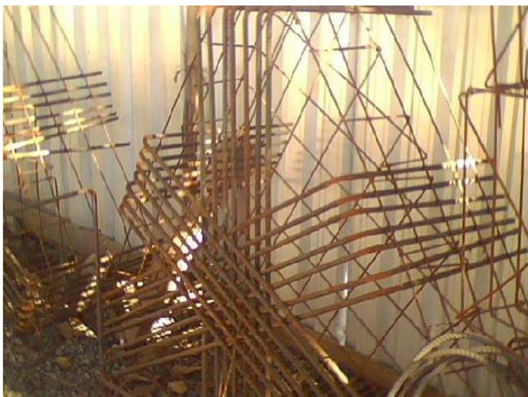
6-Mostra a execução de parte da armadura circular composta de 7 barras de aço de 16mm de diâmetro, circundada por estribos de 5mm de diâmetro, dispostos de forma helicoidal.
