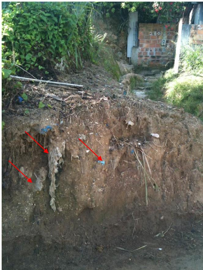
**Fig. 27 – Detalhe do terreno compactado com lixo no Morro do Bumba, Niterói/RJ - Brasil**
