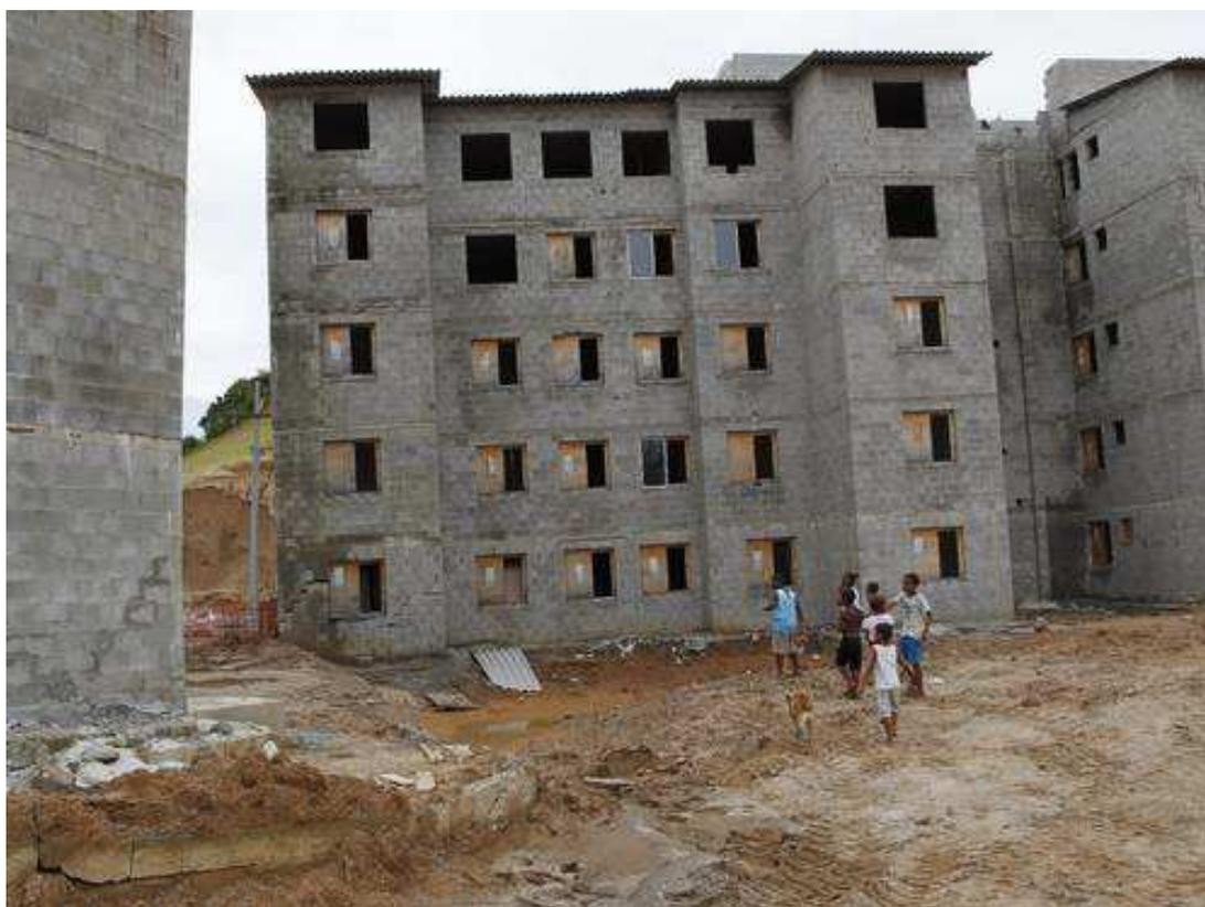
Foto 11: Edifício Demolido Devido à Rachaduras e Construção Fora do Prumo
