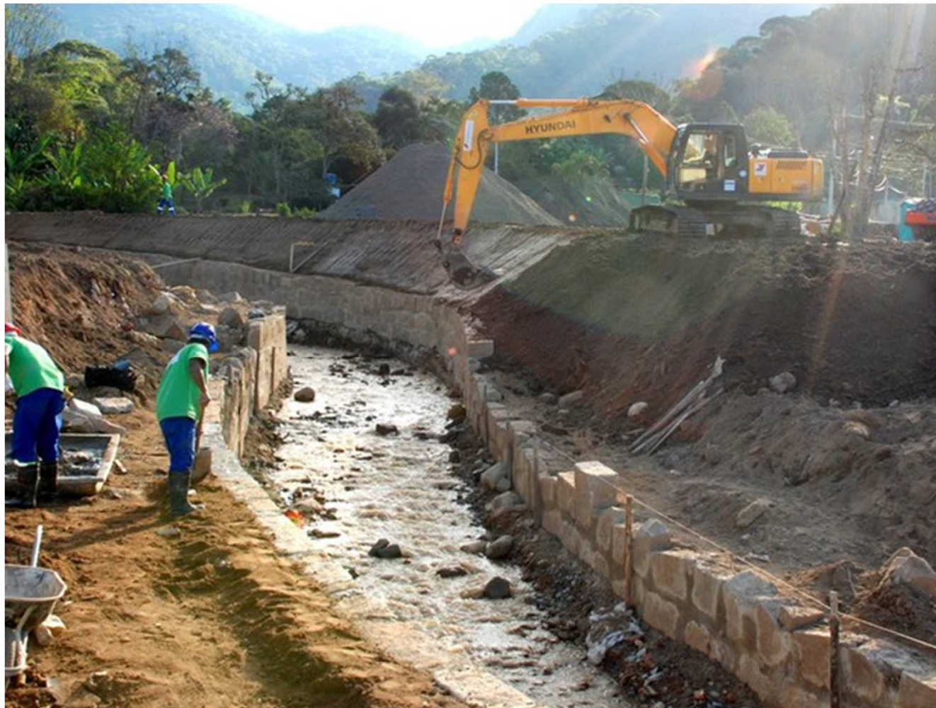
Obras de recuperação – Campo Grande Teresópolis
