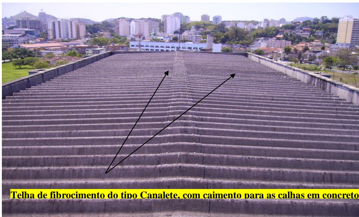
**Foto 19 - Vista parcial de cima da cobertura do bloco “O”. Telhas de fibrocimento com caimento para as calhas de concreto impermeabilizadas**
