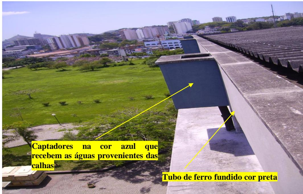
Foto 17 - Detalhamento dos captadores das águas de chuva provenientes das calhas de tubulação vertical em "FF", ferro fundido
