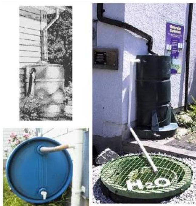
**Foto 5 - Barris utilizados para o armazenamento de água de chuva**
