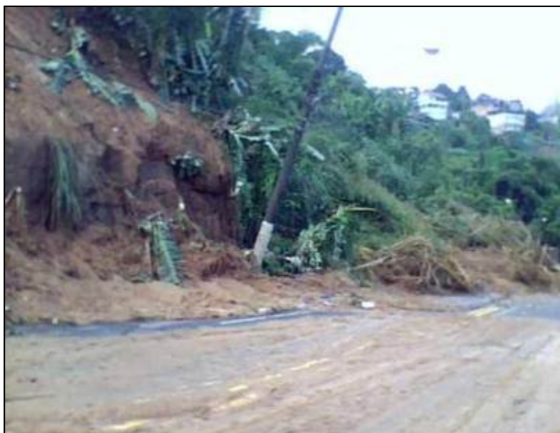
Foto 15 - Deslizamento na Estrada da Cachoeira, Município de Niterói Fonte: FERREIRA, 2010.
