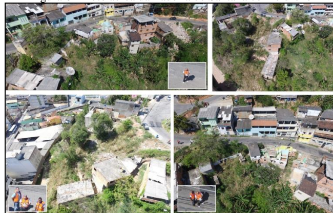
Figura 6 – Foto aérea da Ladeira de Santana com o drone
