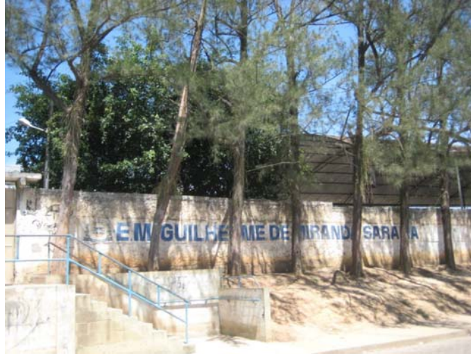
FOTO 7: E.M. GUILHERME DE MIRANDA SARAIVA – ÁREA URBANA
