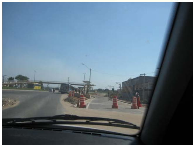
FOTO 14: E.M. PADRE HUGO MONTEDÔNIO RÉGO – ÁREA URBANA - ACESSO BR-101 - MANILHA
