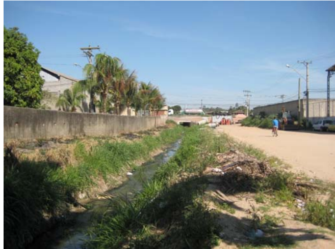
Foto 12: E.M. Padre Hugo Montedônio Rêgo – Área Urbana – Acesso BR-101
