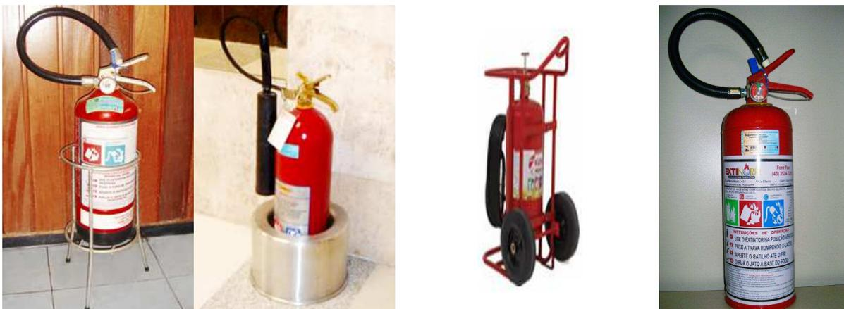
**Figura 14:** Extintores instalados sobre suporte de piso, extintor sobrerrodas e extintor ABC ou multiuso
