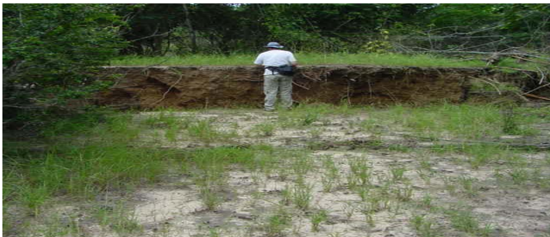
Fig.9. A imagem ilustra uma fratura causada pelo sismo em Machaze, Província de Manica em 22 de fevereiro de 2006 Fotos: Geraldo Valoi & Celestino de Sousa, Apaudo Angelo Cumbe
