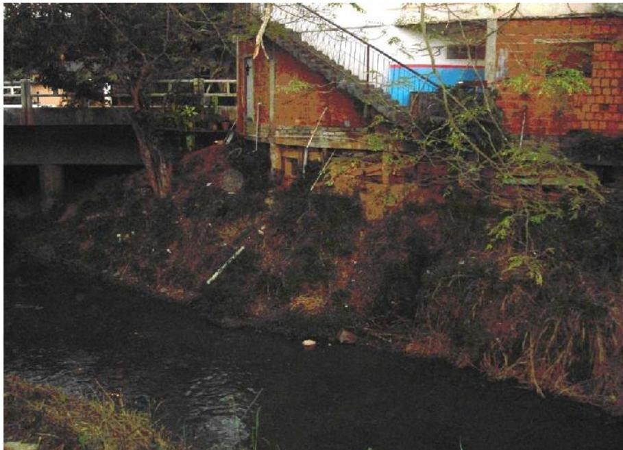
Figura 26 - Ponte sobre o rio Muqui localizada no centro da cidade. Ocorrência de alagamento devido ao nível da viga da ponte ( muito baixo ).
