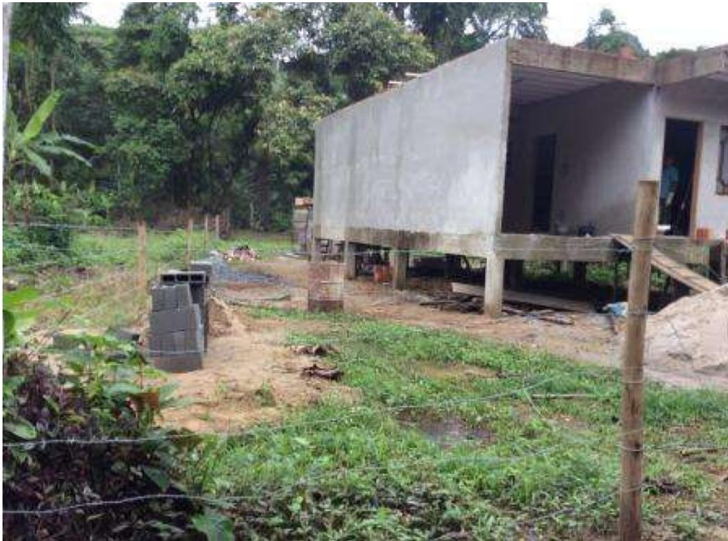
Figura 24 - Casas construídas sobre pilotis para prevenir as inundações.
