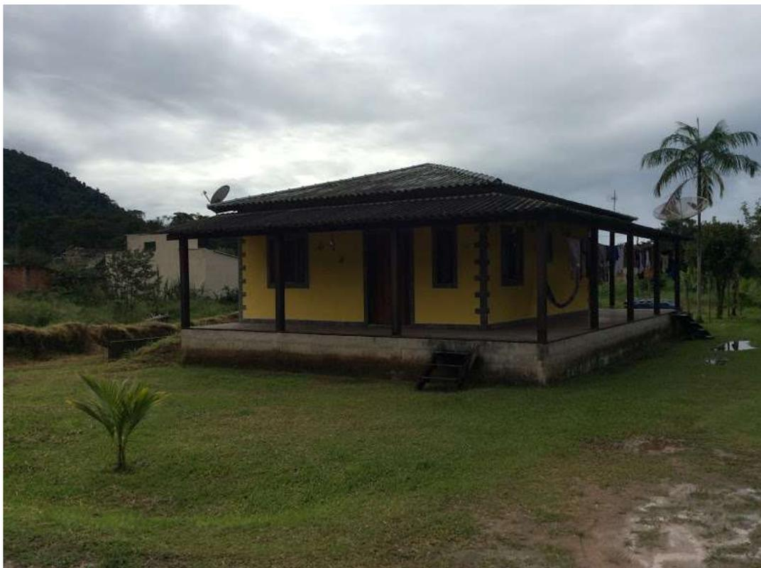
Figura 25 - Casas construídas em nível elevado para prevenir as inundações.
